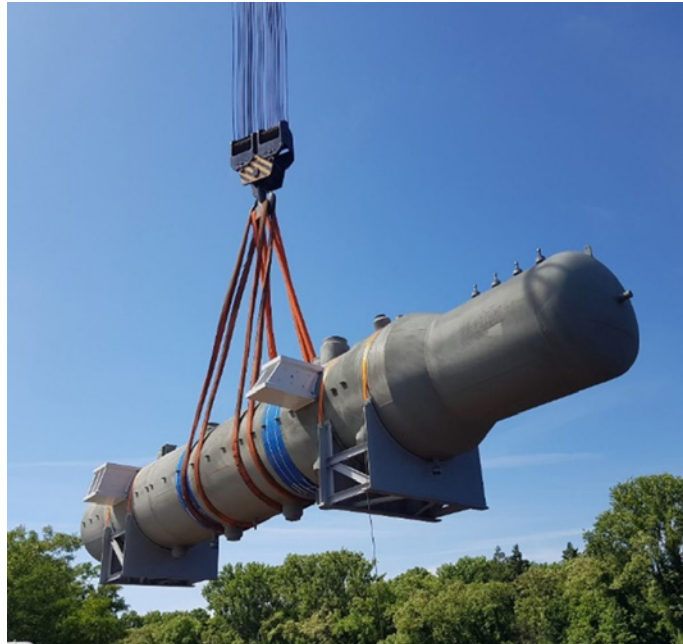
◀ Bild 6. Beispielbild eines sogenannten Waste Heat Boilers für eine Ammoniak-Produktionsanlage, manuell MAG-engspaltgeschweißt
