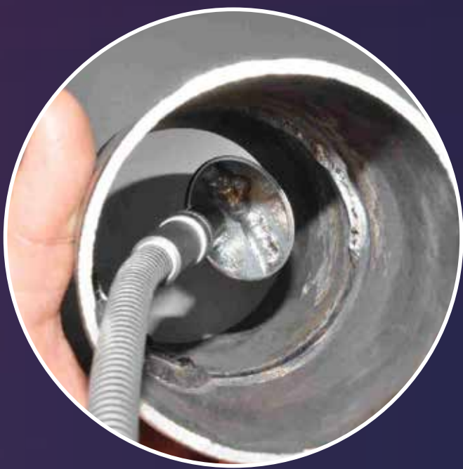
Mit einem beleuchteten Spiegel als Hilfsmittel wird hier die Wurzel einer Rohrschweißung überprüft.
