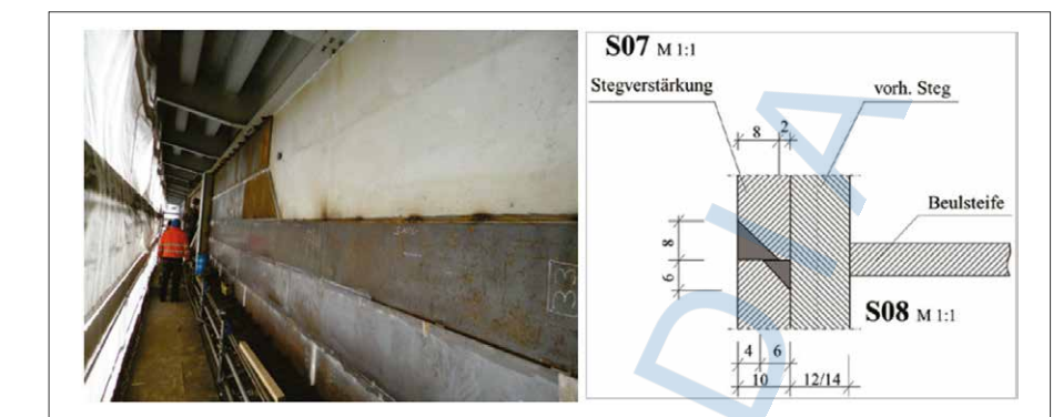
Bild 16: Anbringen von Verstärkungsplatten am Längsträger (links) und konzipierte Nahtvariante zur Stegverstärkung (rechts) als ein Beispiel für schweißtechnische Ertüchtigungsmaßnahmen.
