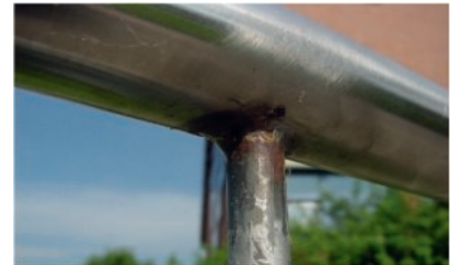
Bild 1. Angerostete Stellen im Bereich der Schweißverbindung eines Geländers aus nichtrostendem Stahl, vermutlich verursacht durch eingetragene Eisenpartikel
