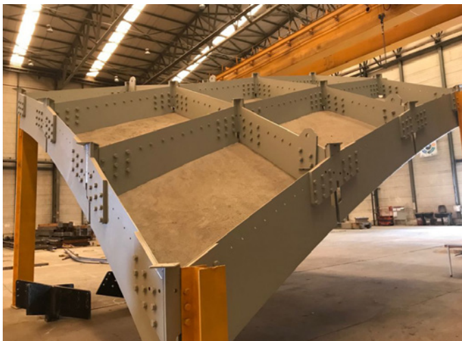
▲ Bild 14. Dachsegment mit Innenbeplankung vor Ort
